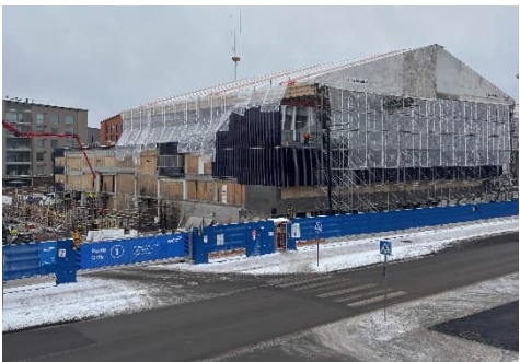
Kuva 1–3. Laajennusosan sääsuoja on valmis ja ensi viikolla aloitetaan D-rungon asennukset.
