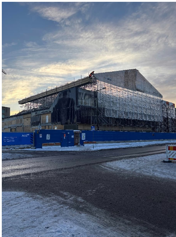
Kuva 1–3. Laajennusosan sääsuoja on valmis ja ensi viikolla aloitetaan D-rungon asennukset.
