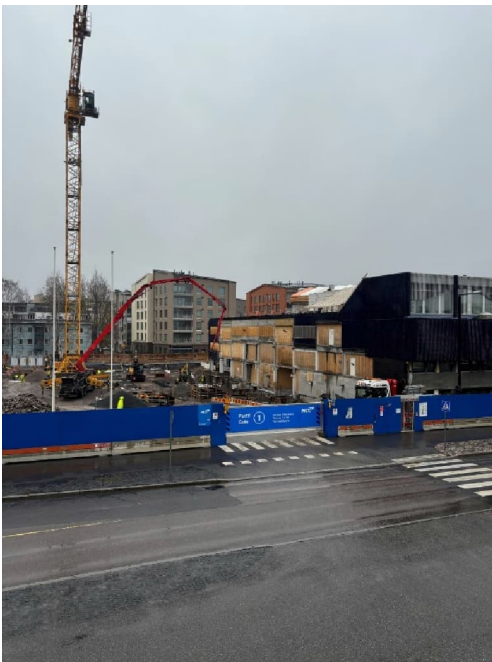
Kuva 1 ja 2. Uudisosan perustusten valut käynnissä 1.11.2024.
