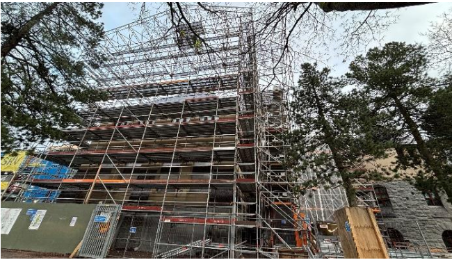
Kuva 2. Telineasennuksia 2. vaiheella.
