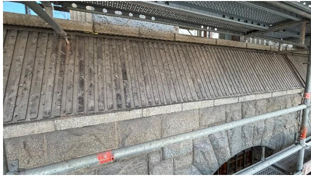
Kuva 8. Liuskekivien purkua Kansantieteellisen osan itäpuolella.
