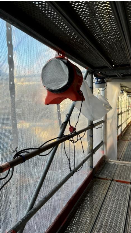
Kuva 4. Pölynhallintaa julkisivun purkutöissä.
