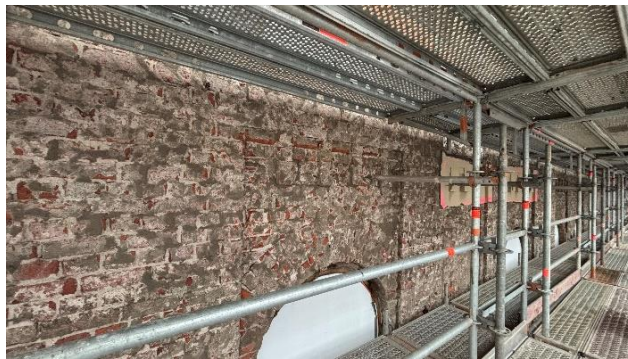
Kuva 6. Vanhat julkisivurappaukset poistettu Virastosiiven länsipuolella.
