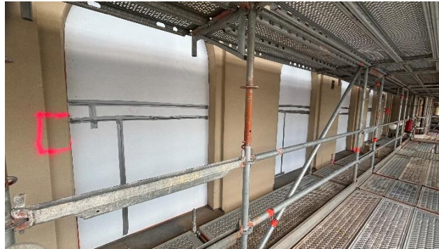
Kuva 5. Ikkunasuojauksia julkisivulla.
