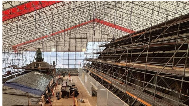
Kuva 9. Kattotyöt 3. vaiheella käynnissä.
