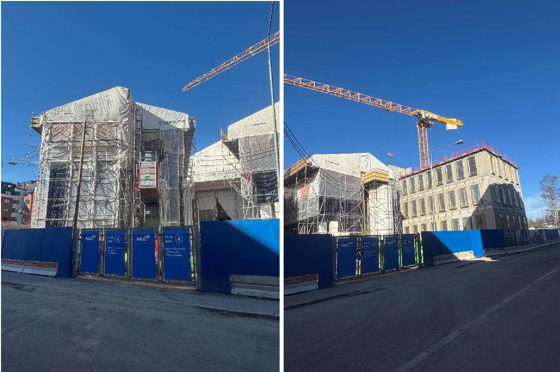
Kuva 1 ja 2. Näkymä työmaan korjaus- ja laajennusosasta Esikkotien puolelta.
