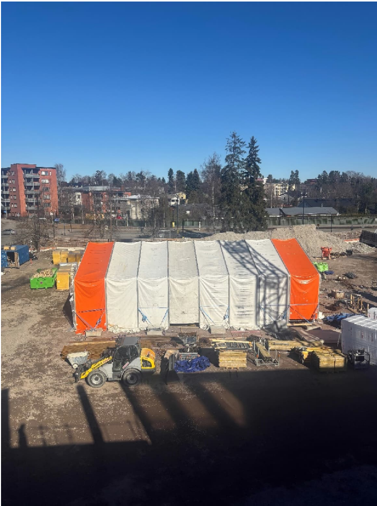
Kuva 1. Tontin pohjoisosalla sijaitsee työmaan logistiikka- ja varastointialue.
