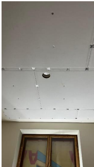
Kuva 2. Levyjen kiinnitys.
