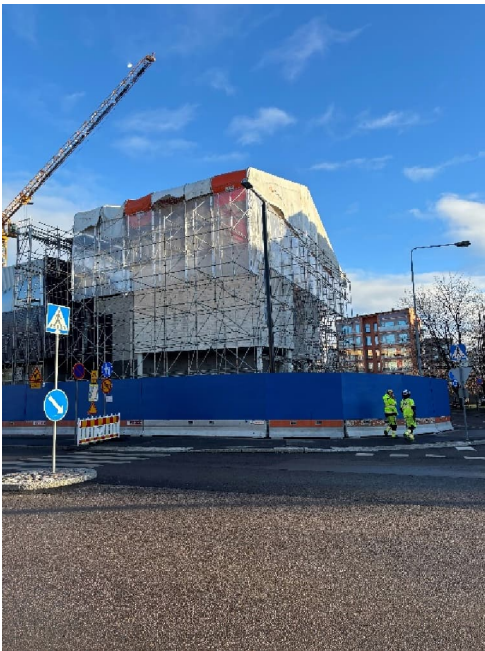
Kuva 1 ja 2. Sääsuojan osa-alueet rakenteilla. Viikon sääolosuhteet ovat vaihtuneet auringonpaisteesta lumimyräkkään.
