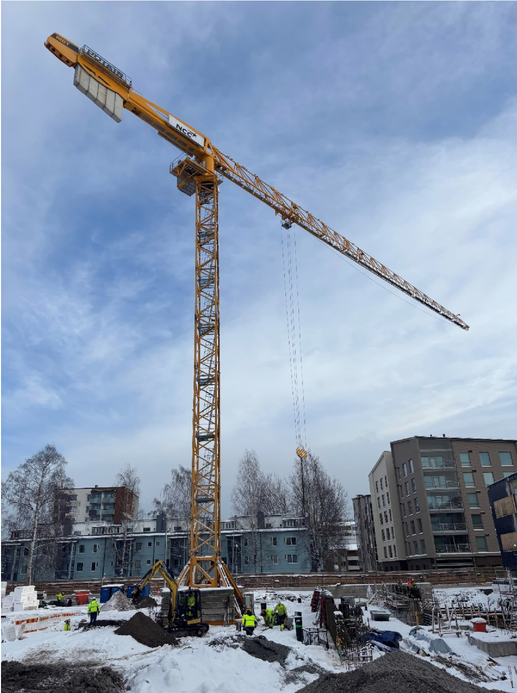
Kuva 3. Ensilumi satoi Tikkurilaan ja työmaa sai valkoisen lumipeitteen.
