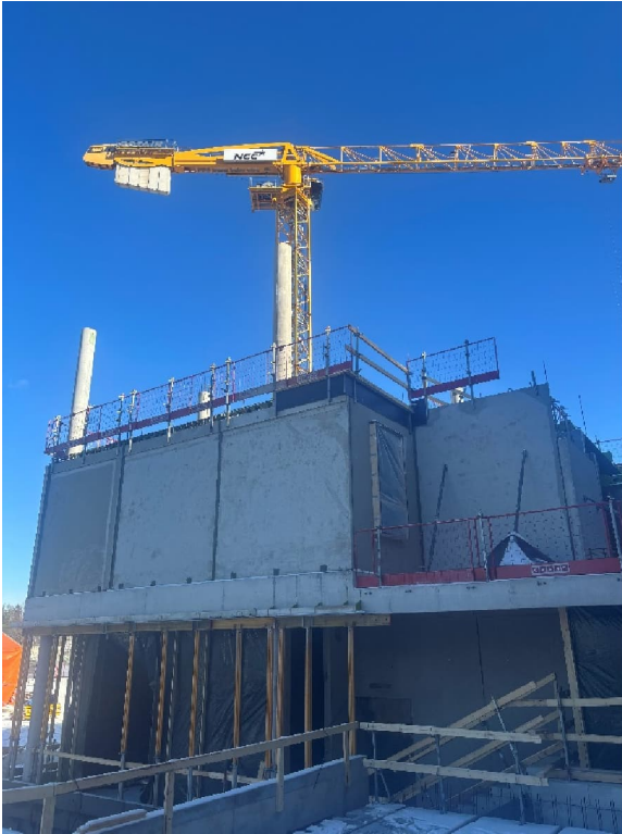
Kuva 1 ja 2. Pääsisäänkäynnin seinät on valettu.
