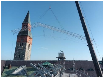
Kuva 1. Kattotuolien nostoa. Valokuva, Valdek Pilv
