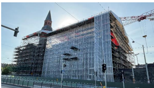
Kuva 7. Sääsuojan ulkopeitteiden asennusta.
