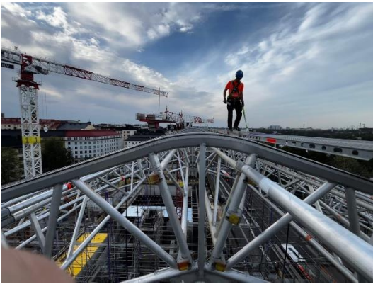
Kuva 2-3. Kattotuolien asennusta. Valokuva, Valdek Pilv
