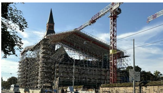
Kuva 6. Sääsuojan kattopeitekankaan asennusta.
