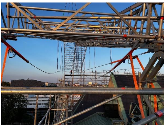
Kuva 4-5. Kattotuolien asennusta. Valokuva, Valdek Pilv
