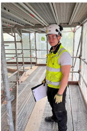
Kuva 4. Joonas Ruotsalainen tarkastamassa telineitä museon julkisivulla.
